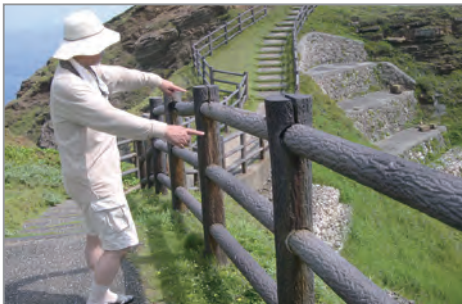
写真 3 樹脂製擬木の塩害（沖縄）
