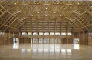
一般流通材を用いた中大規模建築（杉ムク材）
