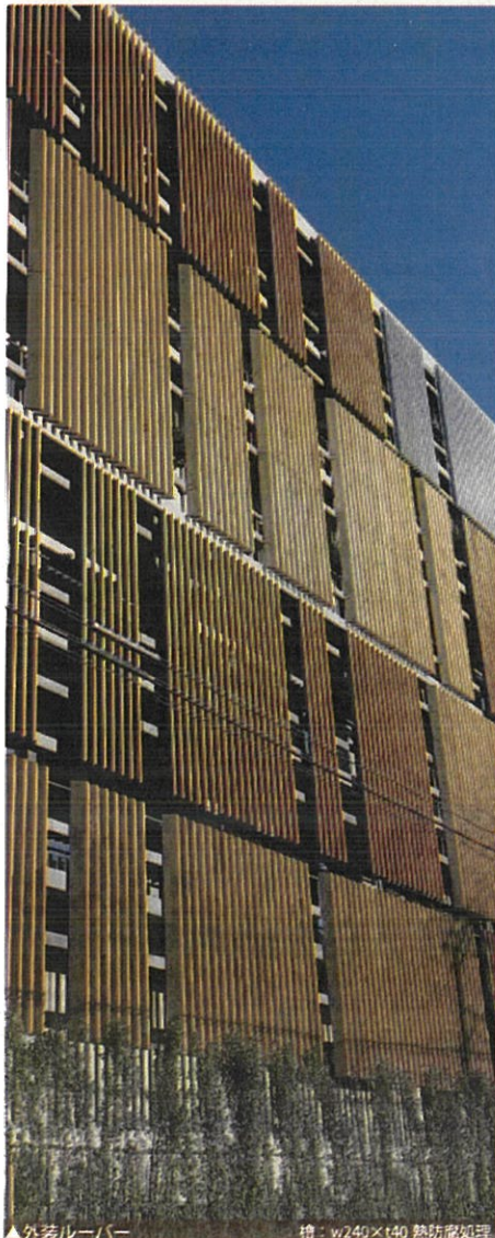
▲外装ルーバー
