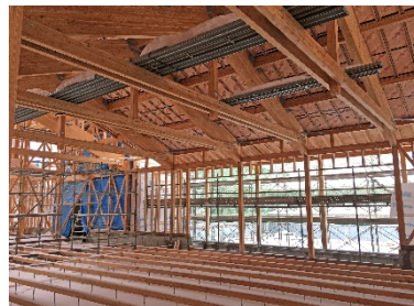
地域産材による架構
