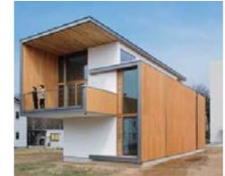
CLT工法による実験棟
