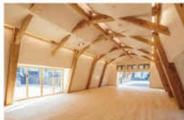
2階遊戯室部分の造形内装シザーズ張付トラスの小屋根と内装の合わせによる柔調
