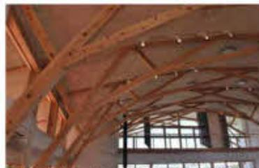
スギ120角製材の樹状方杖架構による13.65mスパン遊戯室
