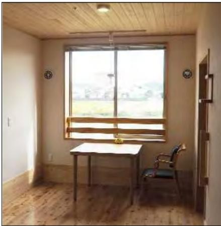
入居棟の天井は、共用部分は木材、廊下はクロスと仕様を使い分けることによって、空間にメリハリを持たせている。スプリンクラーの設備と排煙設備の設置により、内装制限を回避でき、クロスだけでなく木材を使用可能としている。
