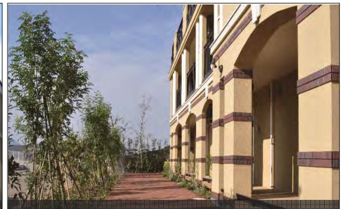
計画当時は、香川県初の桝組壁工法による大規模耐火建築物であり、消防に計画内容を理解してもらうために何度も事前協議を実施し、告示による排煙免除適用における下地・仕上不燃の要求事項に関する木造耐火の考え方についての調整を行っている。外壁は、モルタル下地吹付仕上げによる耐火構造の湿式外壁を採用している。日本ツーバイフォー建築協会が取得した1時間耐火認定仕様以外に、メーカー個別の大臣認定を活用することで、要望を満たす外観デザインを実現している。設備配管等の貫通部材として中空壁用の耐火貫通部材の大臣認定をメーカーと共同して取得している。
