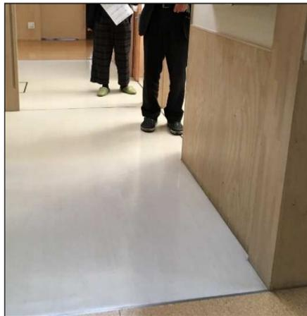
居住エリアのユニットに備わるトイレ・洗面・洗濯スペースの床材は、抗菌性長尺シートを採用している。
