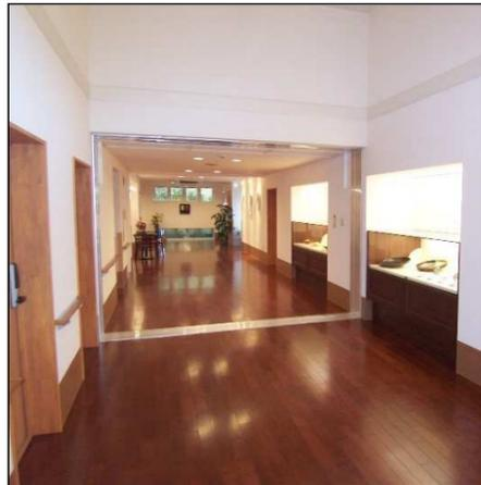
平屋部分（管理・デイサービス）と3階建て部分（特養）を構造的に分棟化し、エキスパンションジョイントを設けている。
