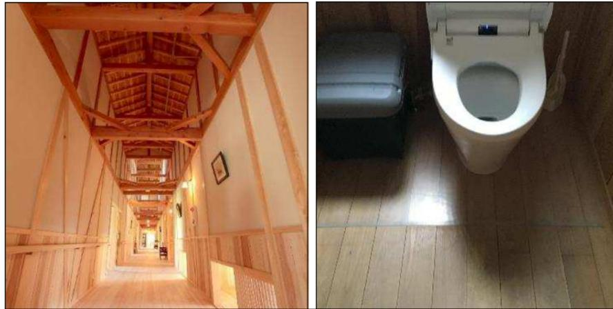
床一面に超仕上げをかけたヒノキ無垢材18mmを張っている。水廻りは、一部上から透明なシートを貼るなど工夫して利用している。ヒノキの水はけの良さなど木の特性を、設計者と運営者が頻繁に情報共有することで、トイレも意識的に水拭き掃除のみとしている。
