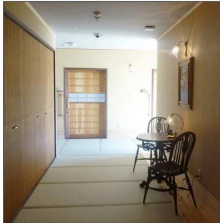
有料老人ホームの廊下は、畳を採用している。落ち着きのある空間をつくるだけでなく、転倒時の衝撃に備えている。
