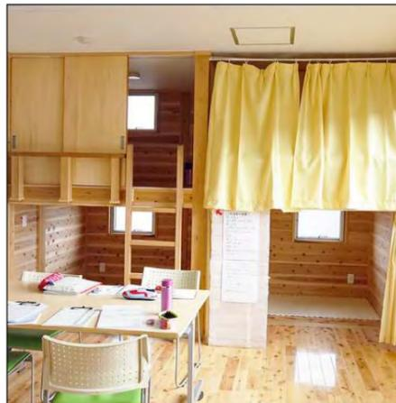
心を落ち着けるよう、木で囲まれた小さな空間を設けている。天井を準不燃材料とすることで、壁一面を板張りとしている。
