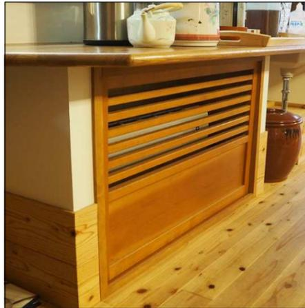
床下に設置された空調機は、壁掛けエアコンを床下に噴き出して空気床下冷暖房としており、効果を実感する声が聞かれる。
