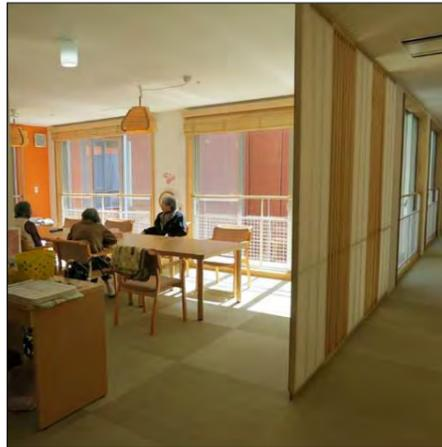
部分的に格子と障子を組み合わせさせた仕切りを設けている。障子は太鼓張りとし、両面からの意匠に配慮している。
