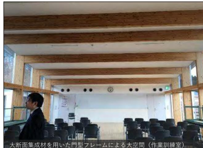
大断面集成材を用いた門型フレームによる大空間（作業訓練室）
