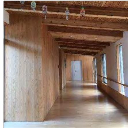
廊下は、床、手すり、窓枠、天井を木質化している。壁は部分的に木質化し、地域産材の杉を用いている。
