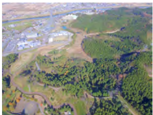
建設地（着工前）
