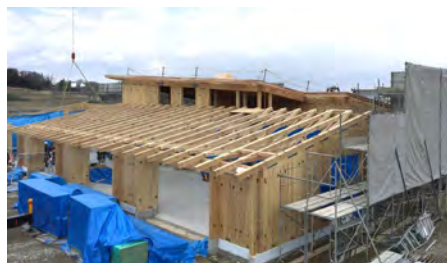
建設地に植林されていた杉を伐採し、 建物の構造材として優先的に活用
