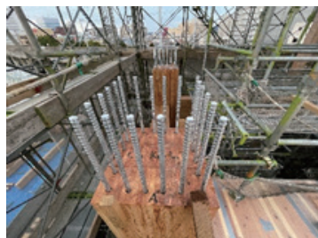
柱を GIR 接合により縦継ぎする
