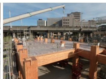
施工状況（2階床）
