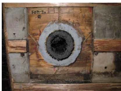
梁貫通孔部分の外観と耐火実験後の試験体
