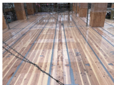
養生シート張付けの様子。 降水時にも下階への漏水等はなかった。
