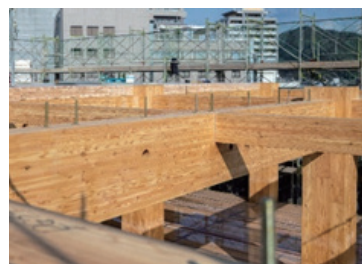
大梁天端にセットした GIR 接合ボルト
