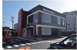
パラベット立ち上げ屋根の実際の店舗の例
