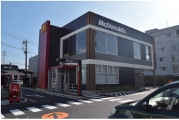
パラベット立ち上げ屋根の実際の店舗の例
