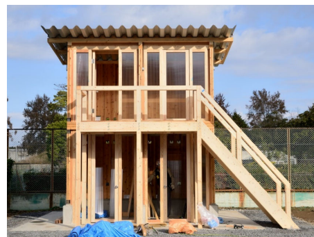
CLT建築の施工コストを 建物で実証
