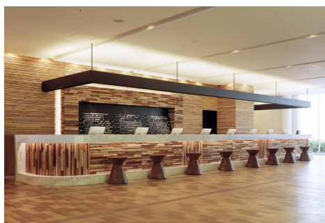
●ケース1の例 ホテルのフロントの内壁に不燃処理木材（樹脂注入）を使用（アワーズイン阪急シングル館）
