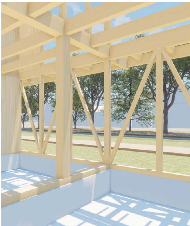
構造躯体・1階内観
