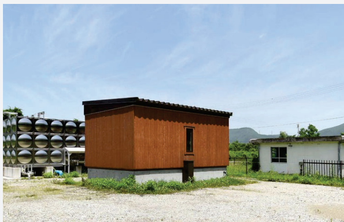
南会津町産のスギ壁パネルを活用した水道施設
