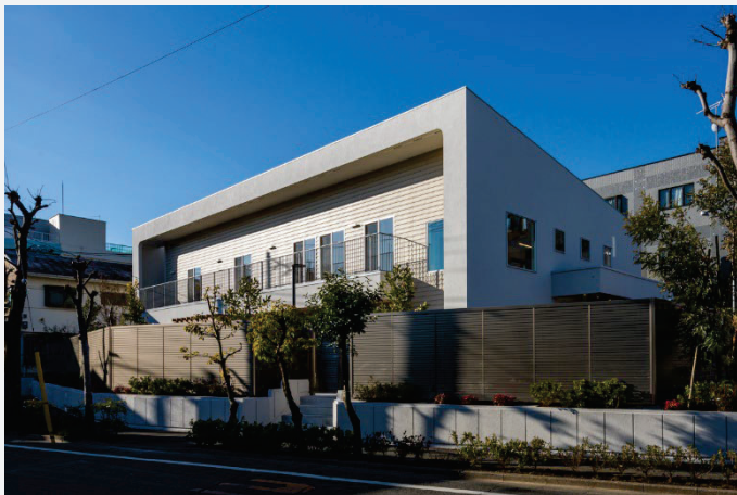
南側の大型門フレームの柱・梁が特徴
