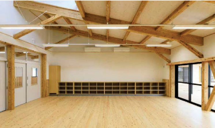
一般流通材サイズ内の大径材を活用したJAS製材の登り梁
