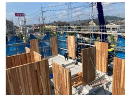
木造事務所建設の様子
