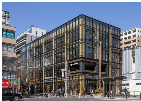
①nonowa国立SOUTH (柱が木造、梁がハイブリッド集成材)
