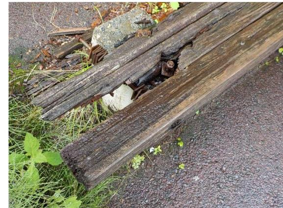
改修前の座面 基礎に座面を直接ボルト止め
