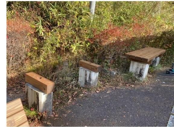
コンクリート基礎と座面の間に台座を入れて高さ調整
