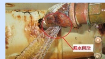
配管の破損
