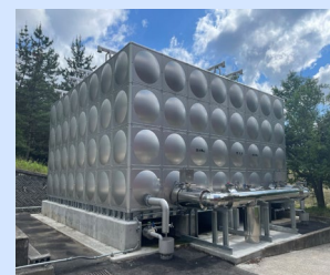
防災機能強化 (ライフライン再生)
