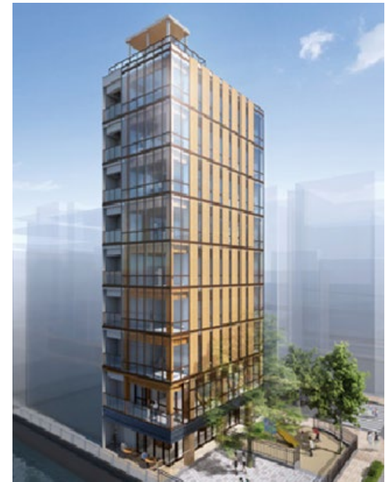
地上9階建て混構造事務所
