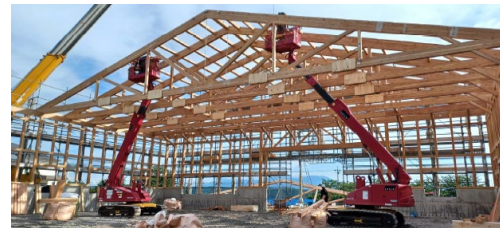
地域材を活用した20m超スパンのトラスを用いて大空間を無柱とする設計の建築物（工場）における実証
