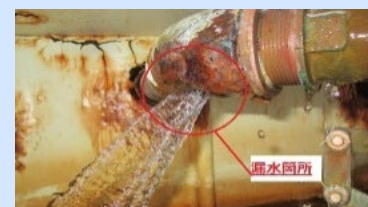
配管の破損
