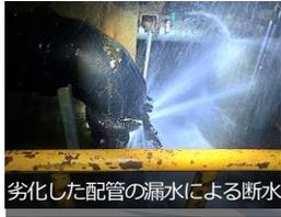
劣化した配管の漏水による断水
