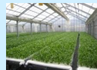
農業生産施設（水耕栽培ハウス）
