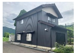
空家を活用した加工場の整備
