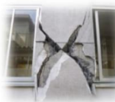
耐震化未完了の建物が大規模地震により甚大な被害を受けた例
