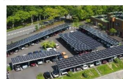
創エネルギー設備の整備
