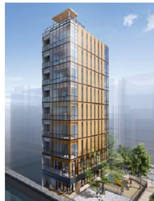
地上9階建て混構造事務所
