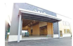
大盤パネルを用いた大空間を実現した取組例 ニヘイ札幌配送センター（石狩市）
