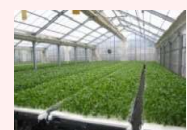
農業生産施設（水耕栽培ハウス）
