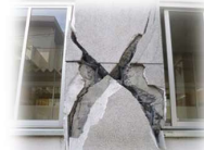
耐震化未完了の建物が大規模地震により甚大な被害を受けた例
