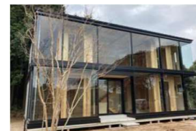
ユニット化しコストを抑えた取組例 CLT CELL UNIT（唐津市）
