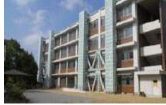
老朽改善された施設
