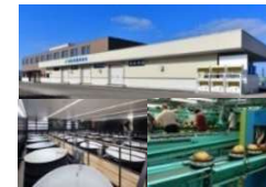
集出荷・貯蔵・加工施設
