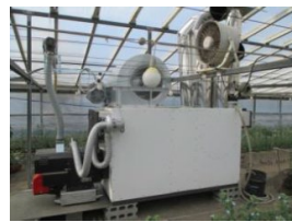
ヒートポンプ
