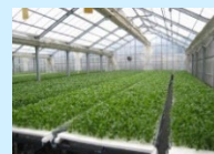
農業生産施設(水耕栽培ハウス)
