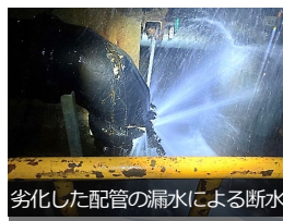
劣化した配管の漏水による断水
