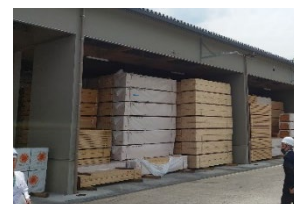
ストックヤードの組み替え等による スギ材を保管する場所の確保
