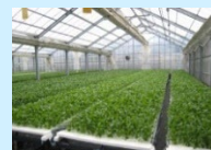
農業生産施設(水耕栽培ハウス)
