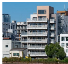
鉄骨造と木造の立面混構造耐震壁にC L Tを利用した取組例
