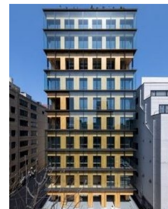
木造11階建ての研修施設
