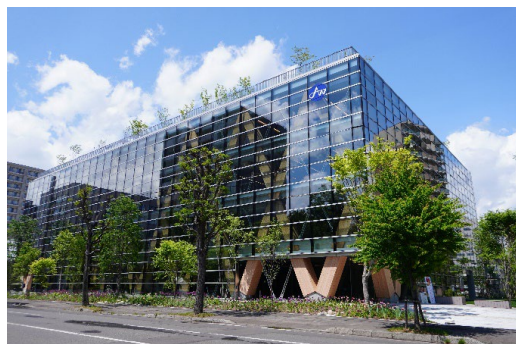
©エア・ウォーター北海道株式会社 エア・ウォーターの森 (北海道札幌市、令和6年10月竣工) [地上4階建て]
