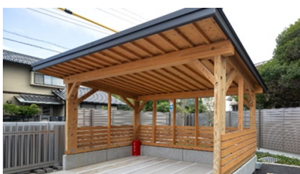
法務省 沼津法務総合庁舎自転車置き場 (静岡県)
