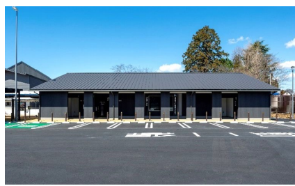
国土交通省 道の駅おけがわ道路休憩施設棟 (埼玉県)
