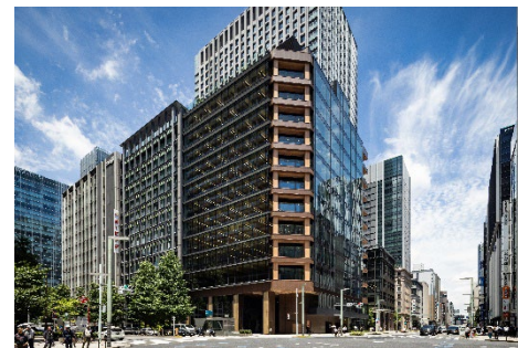
第一生命京橋キノテラス (東京都中央区、令和7年7月竣工) [地上12階建て]
