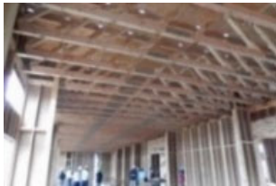
製材による大規模トラス
