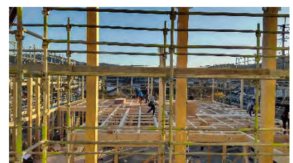
建設中の様子
