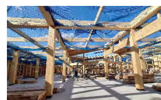
木造店舗の建設の様子
