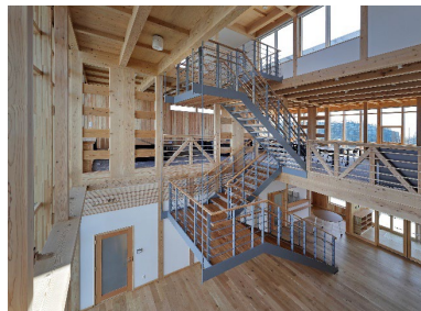
CLTを用いたZEBの事例（東北ボーリング株式会社）
