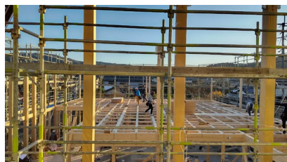
建設中の様子
