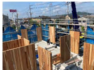
木造事務所建設の様子
