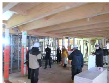
内覧会（施設整備中）の様子
