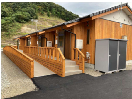
地域材を使用した木造 応急仮設住宅（熊本県）
