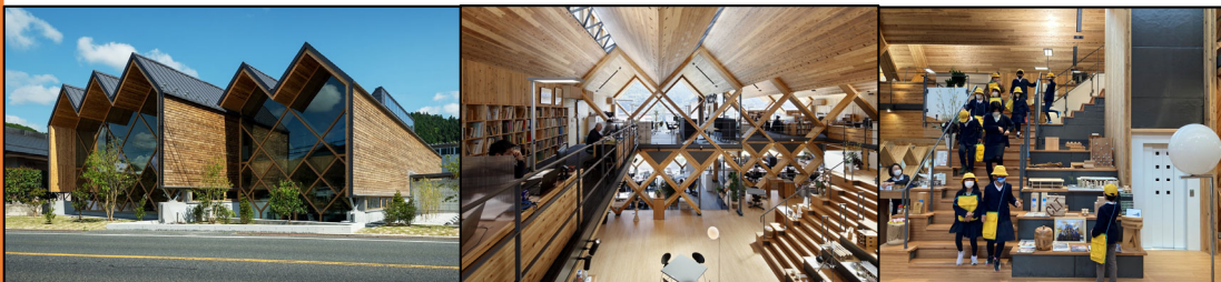
本社事務所（外観） 2020年竣工
