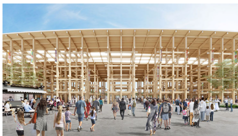
提供：2025年日本国際博覧会協会 ①大屋根リング（施工中）
