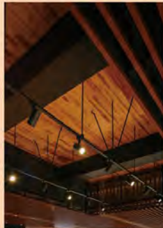
<MIデッキ> 既存のRC造/S造の建築物の天井に「木空間」を実現する型枠材兼仕上材
