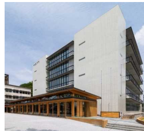
木質耐火部材を用いた大規模庁舎
