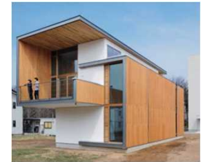
CLT工法による実験棟
