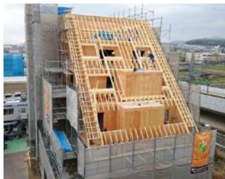
施工中の様子
