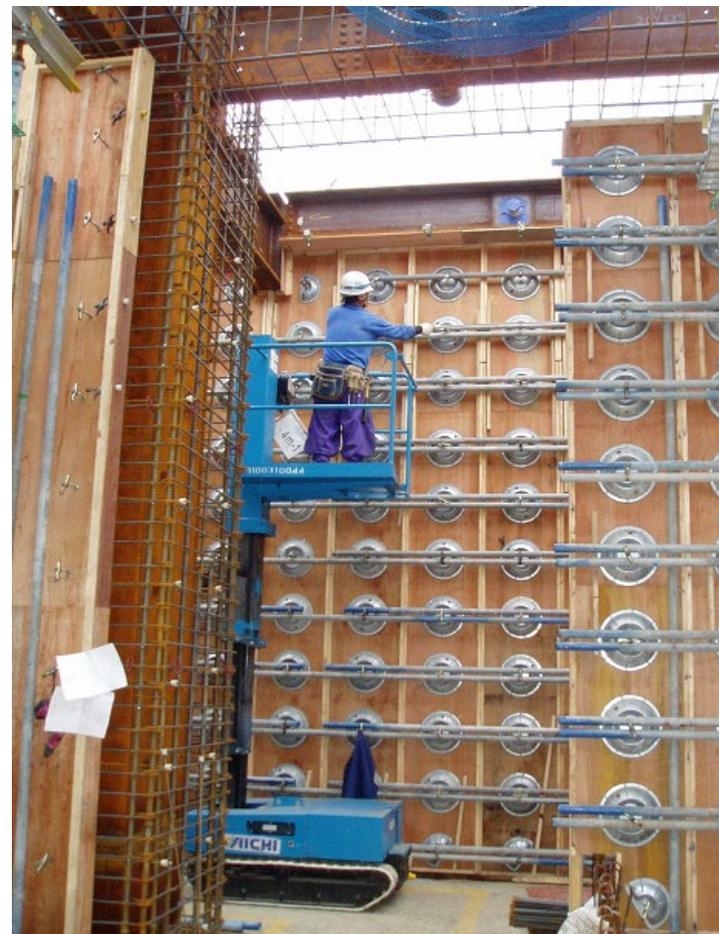
型枠は木材等及び鋼製材等が複合した仮設構造物であり各種の資機材が使用される
