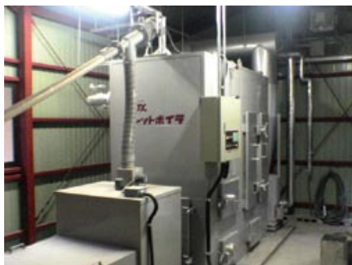
写真 7.4 国産ペレット焚き温水ボイラーとバーナーの構造（二光エンジニアリング）
