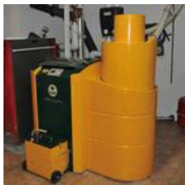
写真 7.9 小型ペレットボイラー (KWB)
