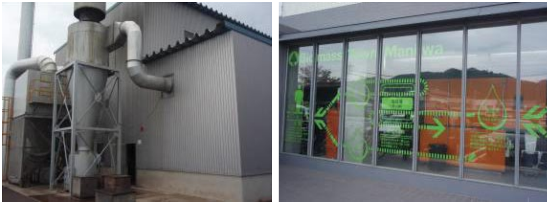
写真 8.1 北海道健誠社のボイラー建屋（左）、真庭市役所の2基のバイオマスボイラー（右）
