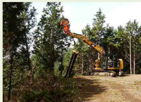
スイングヤーダによる集材（間伐）
