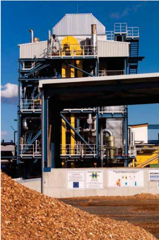
ギュッシングの木材ガス化発電所は2001年に作られ、投資コストは当時900万ユーロだった。一時間に2.5トンものチップを必要としている(年間2,200t)。その燃料で、一時間に1,000m<sup>3</sup>の木材ガスが作られている。それをガスエンジンに送れば、一時間で2,000kWの電気と4,500kWの熱が作れる。
