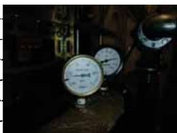
・ 熱交換器出口配管温度、圧力
