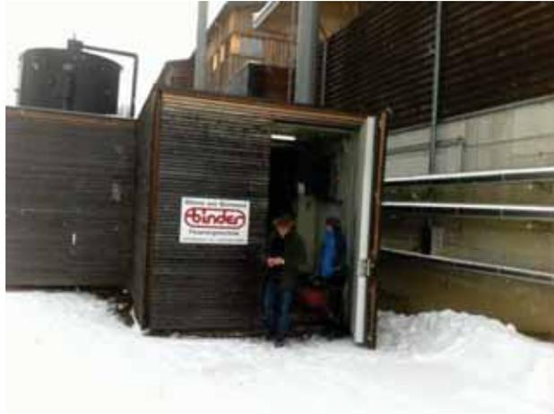
コンテナ式の500kWのチップボイラ
