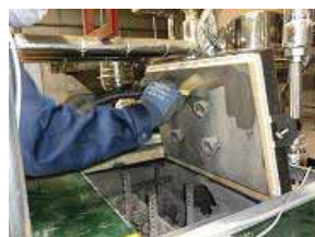
2. ボイラ上部の灰の掃き掃除及び吸引
