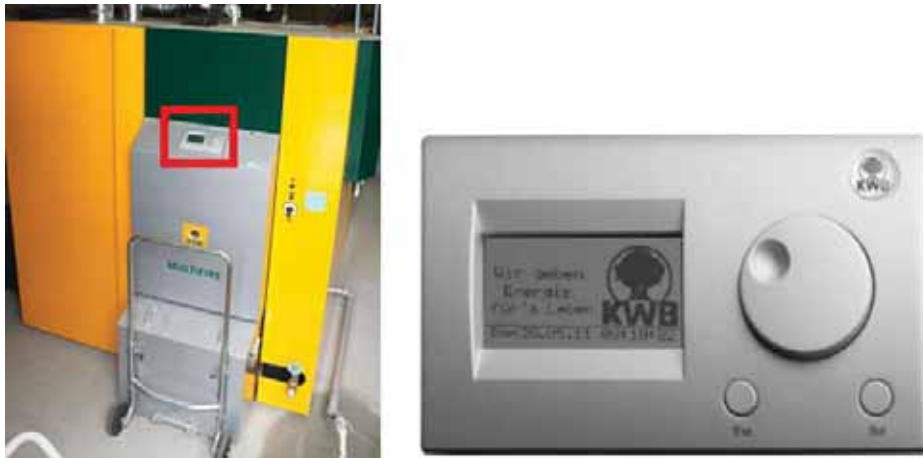
図 4.1 ボイラコントローラーの位置 (左) と拡大写真 (右)
