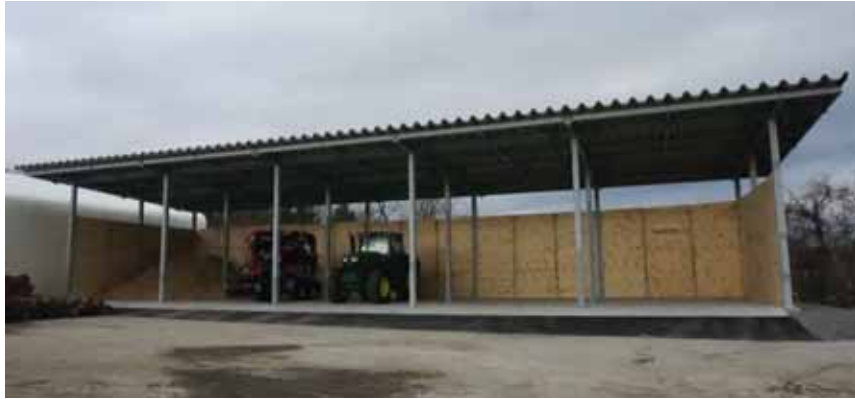
写真 6.1 完成した木くず燃料管理ヤード
