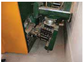
6. ボイラ裏側の金属板すべて取り外し
