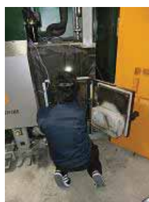
10. 燃烧炉のブロックを戻し、ふた取り付け
