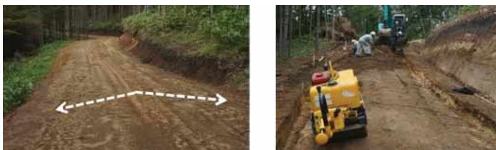
写真 2.8 屋根型路網の施工現場 (鶴居村森林組合)
