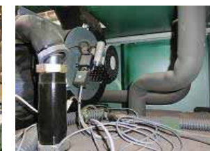
3. ボイラ中のファン取り外し
