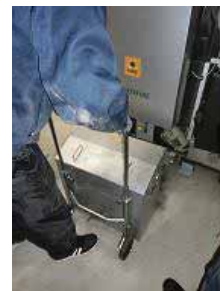
4. 灰コンテナ取り外し
