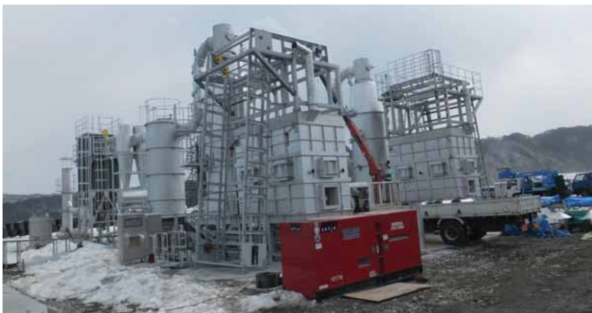
図 4-8 バイオマスボイラの外観（平成 26 年 2 月 25 日撮影）
