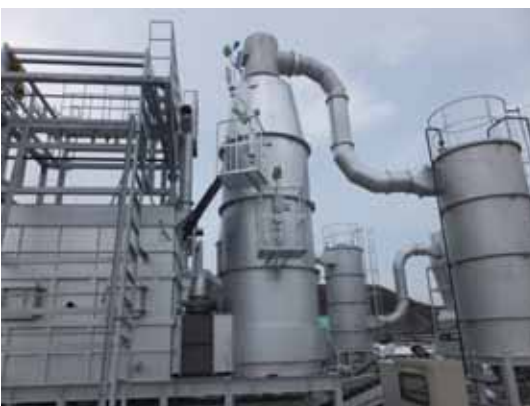
写真：二次燃焼炉 (平成 26 年 2 月 25 日撮影)
