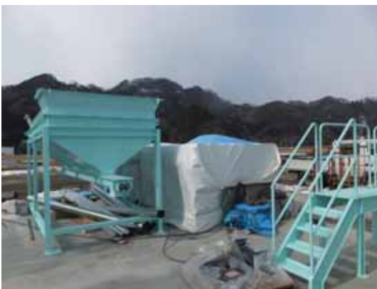
写真：灰資源化施設 (平成 26 年 2 月 25 日撮影)
