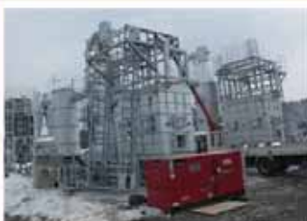
図. バイオマスボイラーの外観 (平成26年2月25日撮影)
