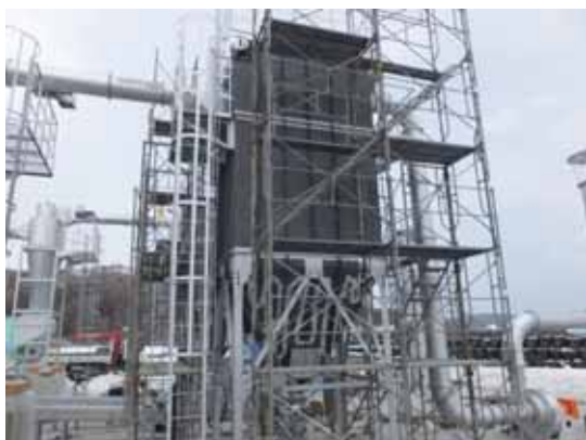
写真：バグフィルタ (平成 26 年 2 月 25 日撮影)
