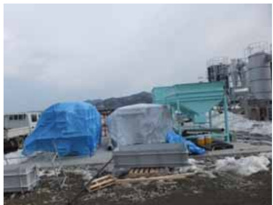
写真：灰資源化施設 (平成 26 年 2 月 25 日撮影)
