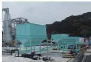
図. 灰資源化施設の外観(平成26年2月25日撮影)
