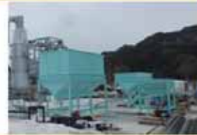
③灰資源化施設
