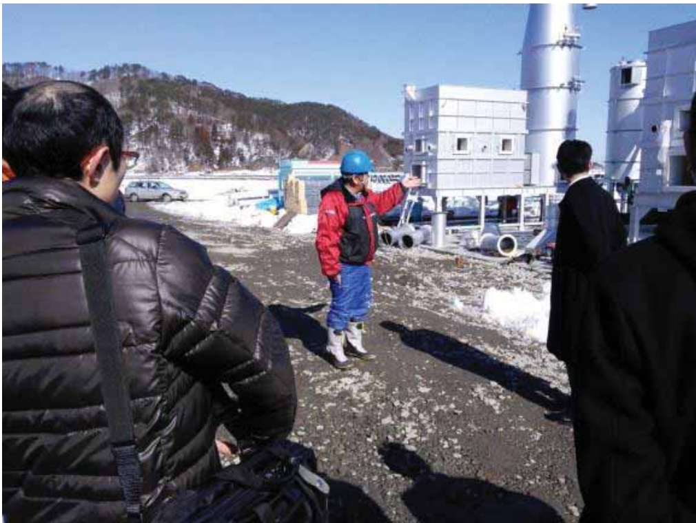
図 3-7 現場説明会（実証施設）（平成 26 年 2 月 13 日撮影）
