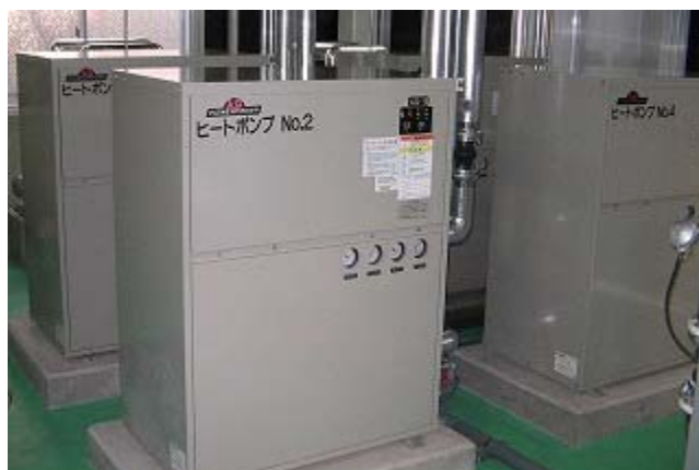
図 3.1-15 地下水利用型ヒートポンプ
