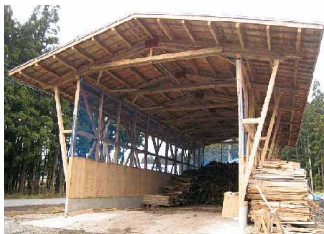
図 3.1-9 燃料用の木質バイオマス貯木場
