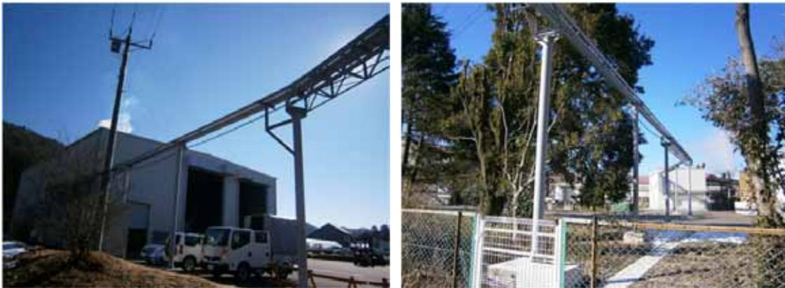
図表 4-7 チップボイラ設置現場（建屋外観と蒸気配管）
