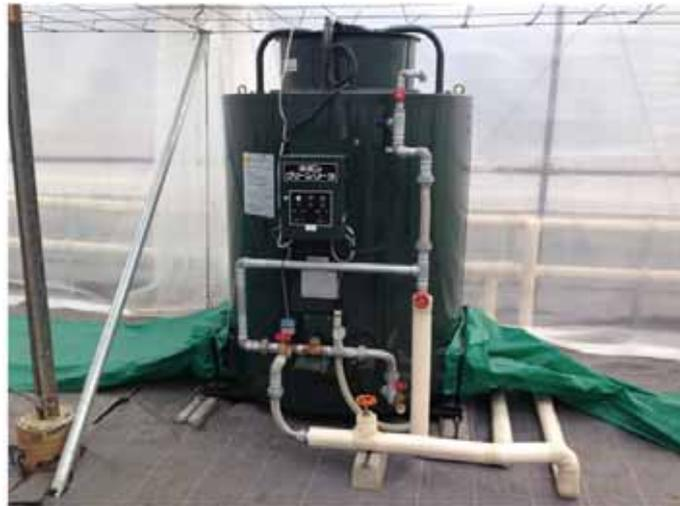
図表 5-7 温水から温風に熱交換する装置（グリーンソーラ）
